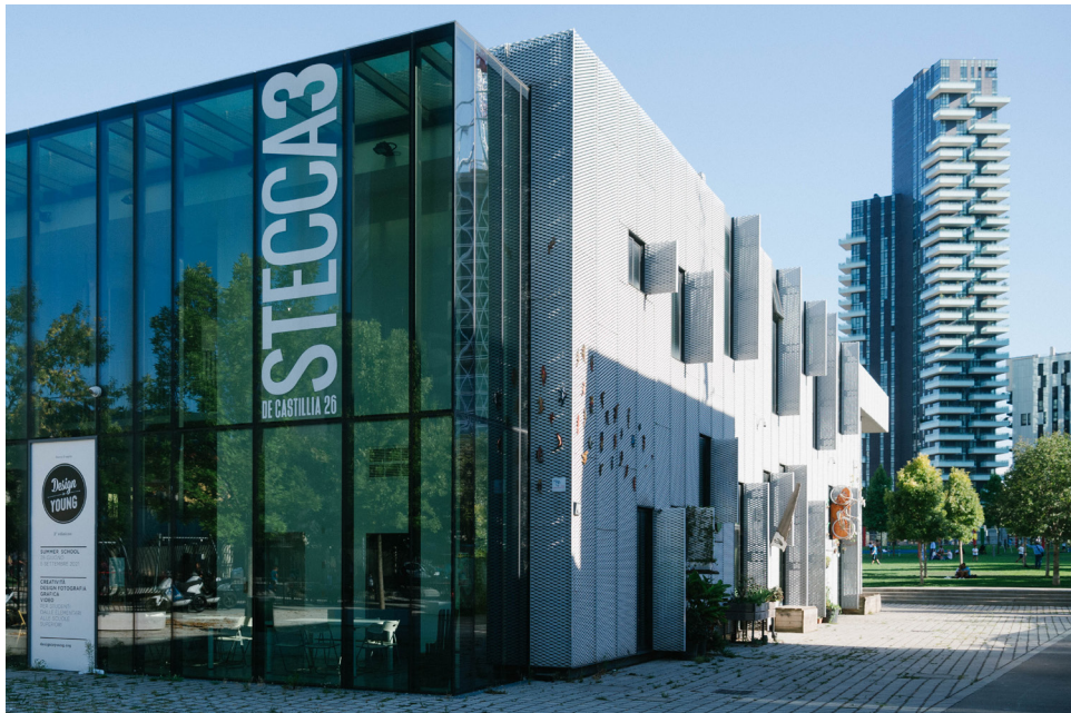
Sala coatelier / laboratorio | Uscita su area esterna di pertinenza
